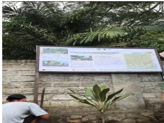
Gamabr 9: Pemasangan papan informasi
